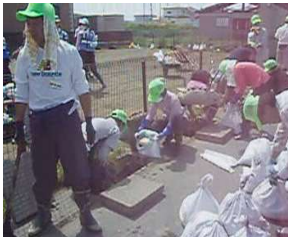
側溝の汚泥の掻きだしの様子
